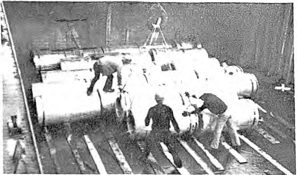
Stauen von Rohren an Bord.
