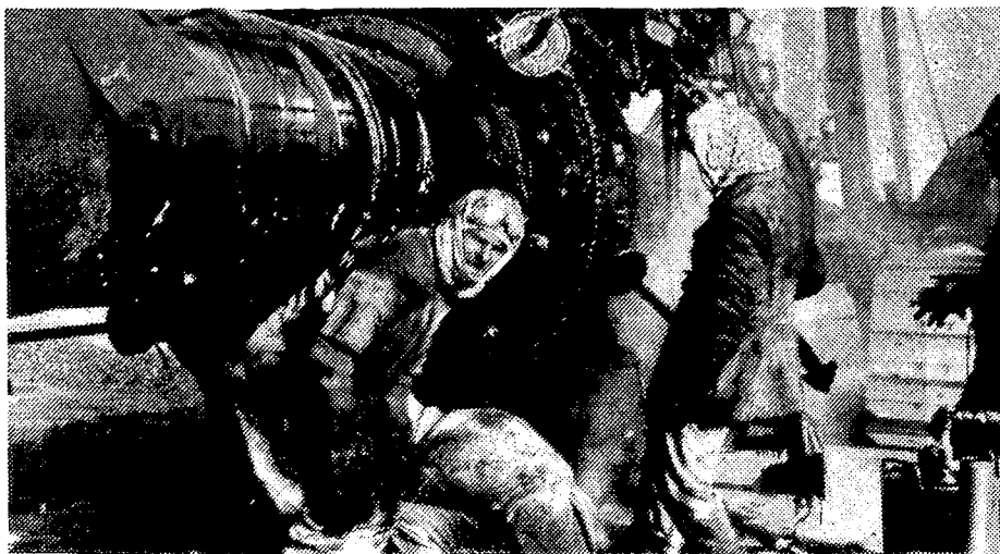
Irakische Arbeiter bei der Verlegung einer Pipeline
