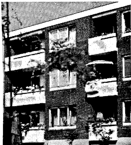
Auf der Abschußliste: der Soziale Wohnungsbau
