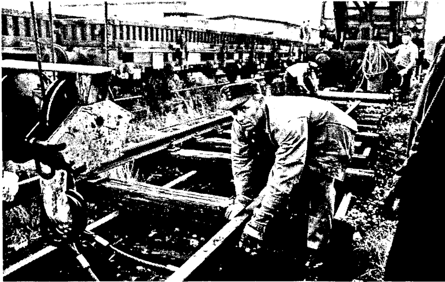
Mit dem neuen Ausländergesetz betreibt die Bundesregierung die Versklavung der ausländischen Lohnarbeiter. Bild: italienische Gleisbauarbeiter.
