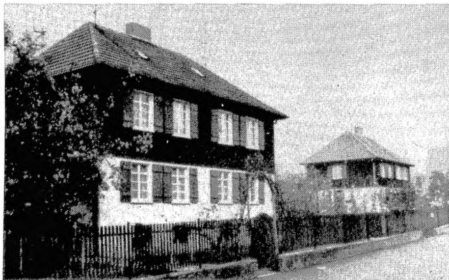
Vier der 14 Zweifamilienhäuser der Promenadensiedlung
