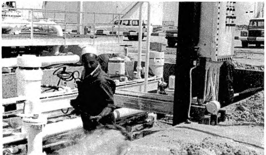
Nach einem der vielen Sandstürme säubern Arbeiter die Pipelines der Erdölalagen des libyschen Gialo-Feldes.
