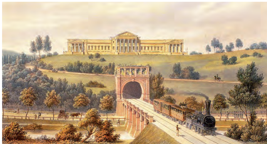
Rosensteintunnel 1845, nach dem Bau der ersten Eisenbahn. Der Stuttgarter Kopfbahnhof befand sich damals beim Schloßplatz; 1914 wurde er an den heutigen Platz verlegt; ein Durchgangsbahnhof scheiterte damals an Technik und Kosten. (Quelle: Wikipedia)
