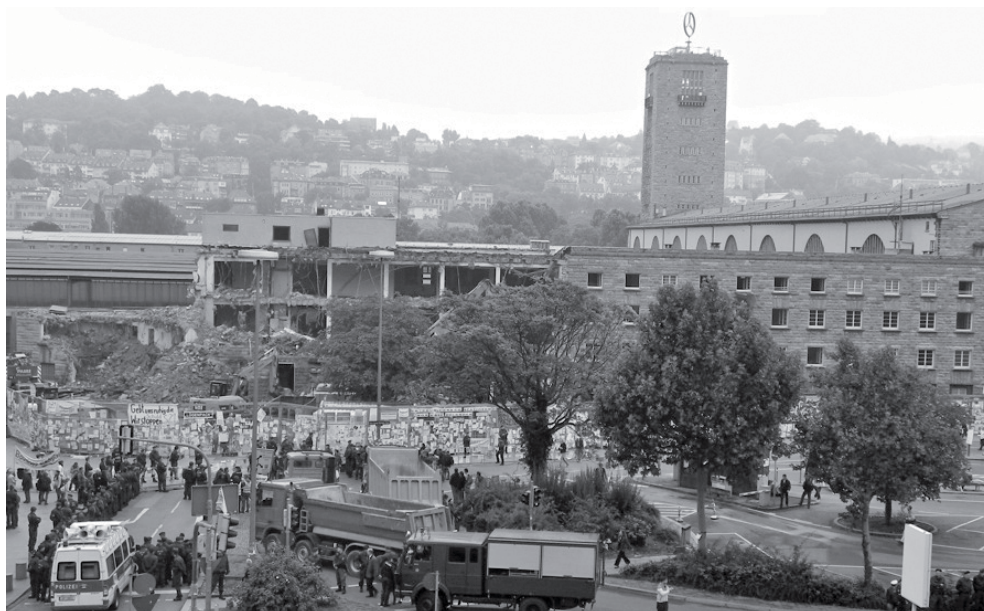
Abriss des Nordflügels des Stuttgarter Bahnhofs unter Polizeischutz
