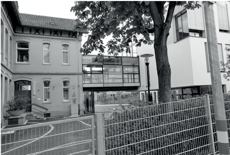
Die Gesellschaft baut derzeit das System Erziehung und Schule in einem gewaltigen Maße um. Die nötigen Bauten (im Bild ein Anbau mit Mensa in der Wilhelmschule Untertürkheim) verschlingen große finanzielle Mittel, etwas was die kommunale Verwaltung aber vergleichsweise gut hinkriegt – schließlich langjährig geübte Praxis. Der Umbau in den Strukturen ist aber bedeutend schwieriger.
